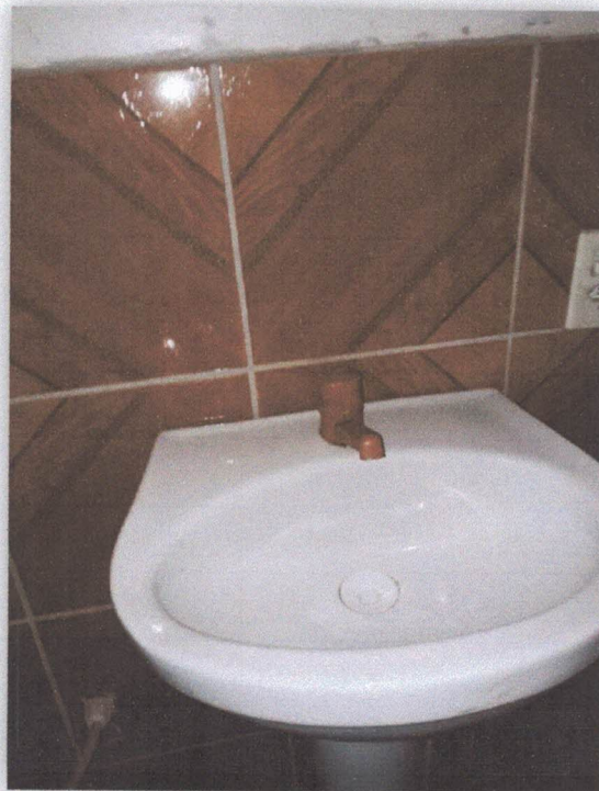
Figura 6: Pia do Banheiro
