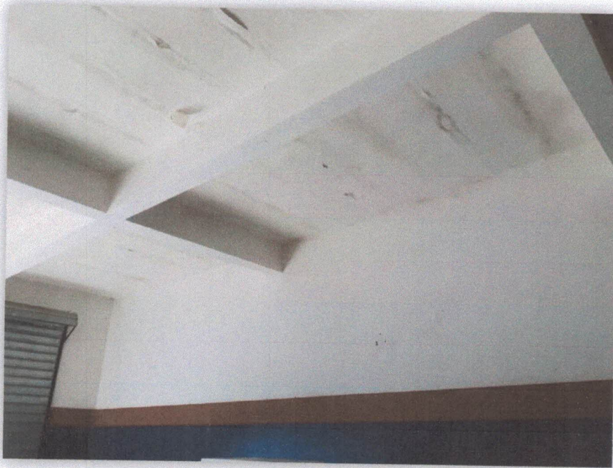
Figura 3: Forro e parede Interna
