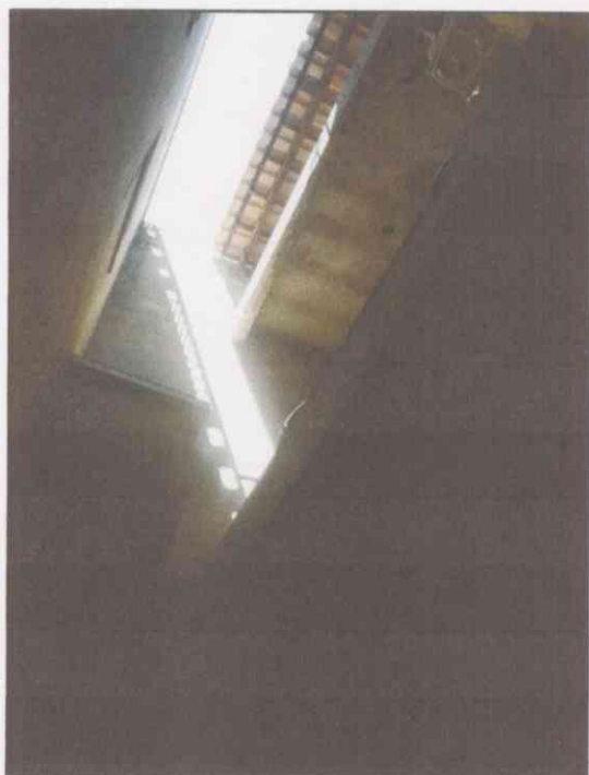
Figura 03 – Parte Interna – Caixa d'água
