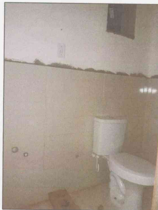
Figura 08 – Parte Interna – Banheiro
